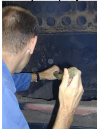
Rys. 10.2. Czyszczenie kotła
