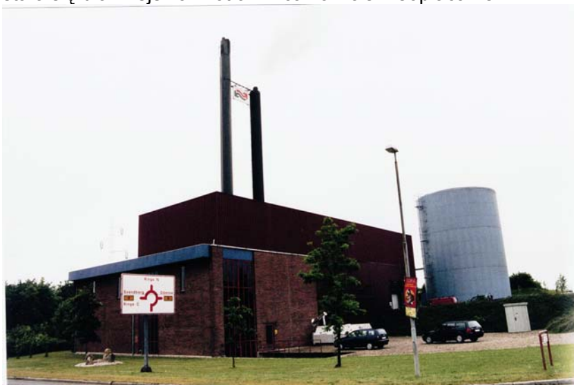
Rys. 11.1 Kotłownia miejska w Ringe wymieniła stare kotły węglowe na kotły spalające pelety
