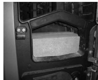
Rys. 7. Umieszczenie płyt szamotowych w kotle KLIMOSZ UNI PELLETS.
