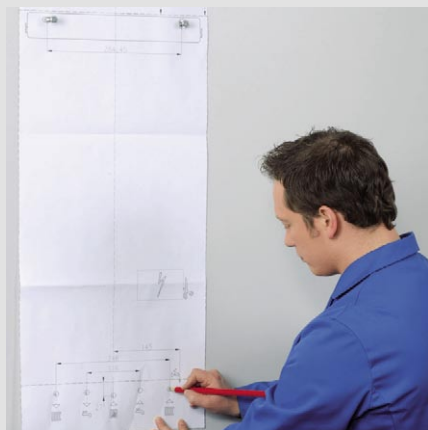
1 Wyprowadzenie przyłączy przy użyciu szablonu
