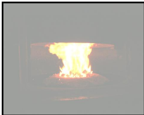
Widok paleniska w kotle 18- 50 kW
