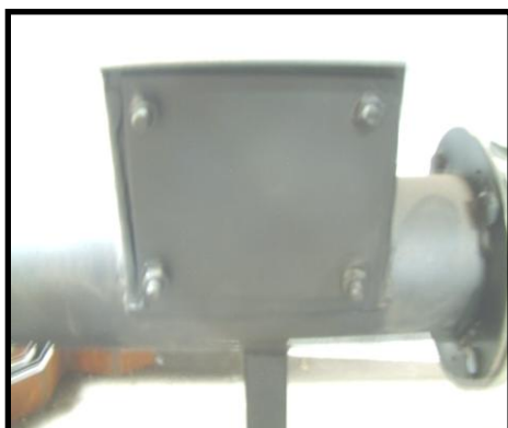
Kłapa rewizyjna w kotle
