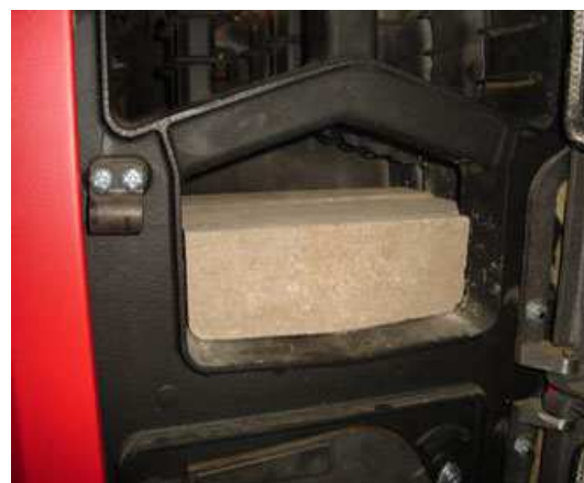
Rys. 11. Umieszczenie katalizatora ceramicznego na półkach wymiennika kotła KLIMOSZ COMBI.
