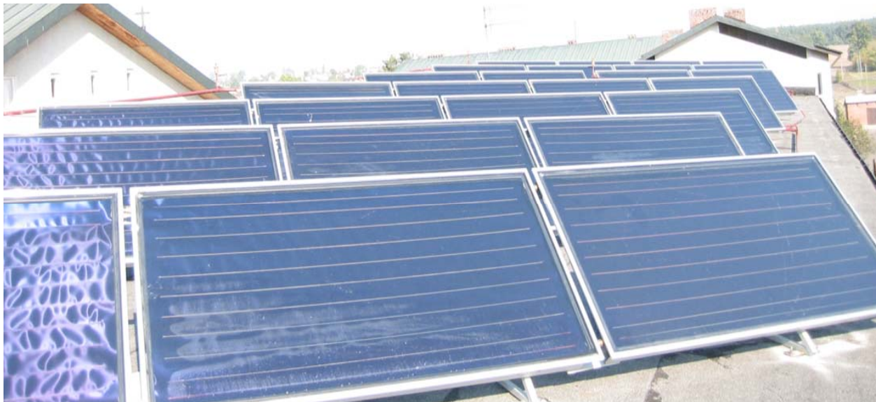
Pole 28 kolektorów WOLF F-3Q w Siedlcach Seminarium Duchowne Powiatu Siedleckiego
