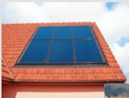
Kolektory słoneczne Vitosol 200-F na budynku jednorodzinny.
