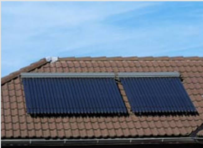
Vitosol 300-T – próżniowy kolektor rurowy na zasadzie Heatpipe
