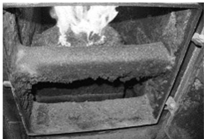
Rys. 13 Komora spalania kotła bardzo brudna.
