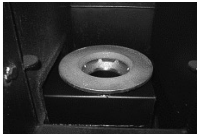
Rys. 14 Komora spalania kotła bardzo czysta.
