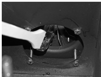
Rys. 161 Wyczyścić śmigło wentylatora
