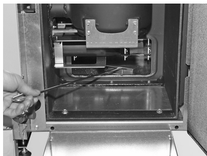
Rys. 132 Popiół spod wymiennika usunąć do szuflady za pomocą skrobaka
